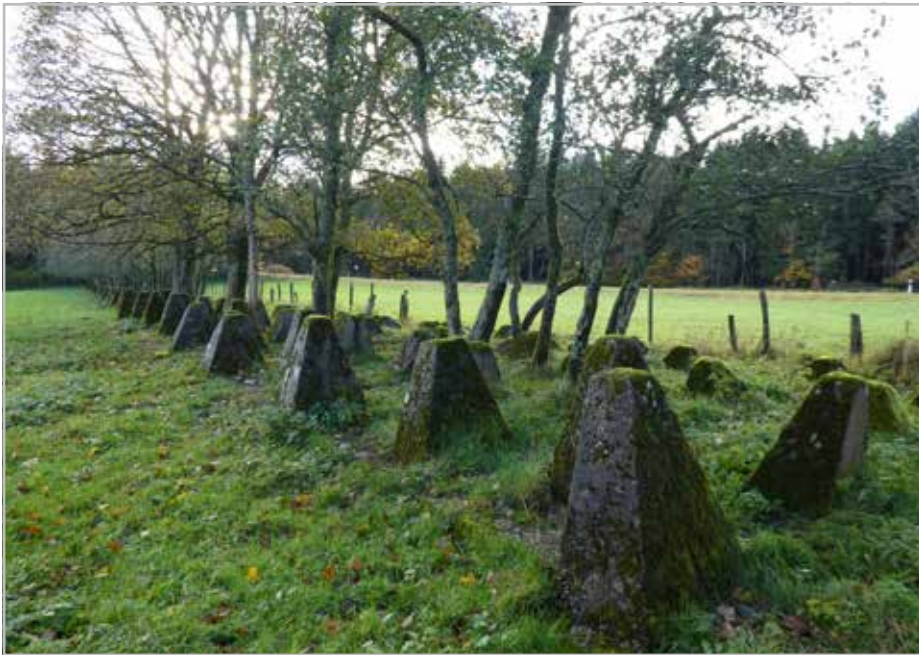
„Drachenzähne“ an der Ramscheider Höhe (zwischen Udenbreth und Hollerath). (Foto: K. Heinrichs)
